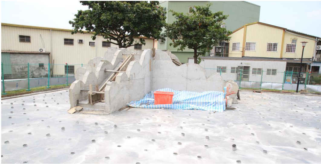
圖6 公園設備皆符合國家安全標準（神岡區豐洲公園，施工中）
