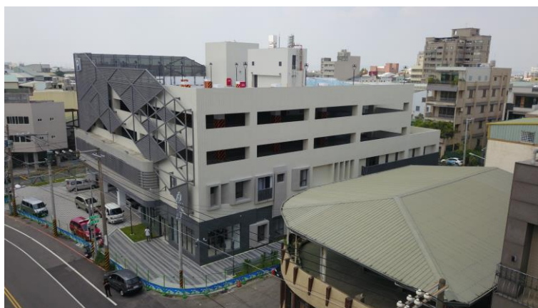
圖 4 豐原區育英路多目標立體停車場暨豐南地區消防分隊完工照片
