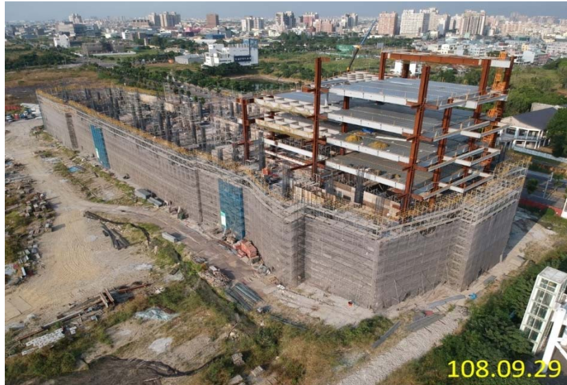
108.09.29 工區現況空拍圖
