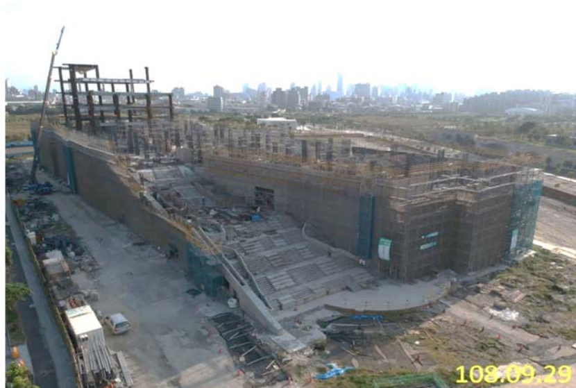
108.09.29 工區現況空拍圖
