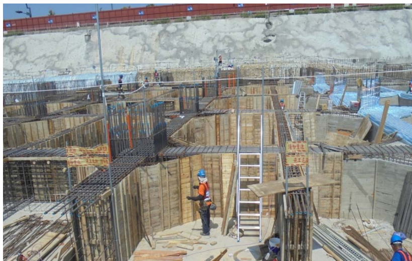
108年9月25日 展覽棟北側筏基地梁模板組立
