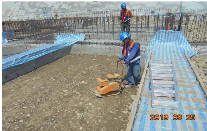
108年9月25日 展覽棟北側筏基層回填
