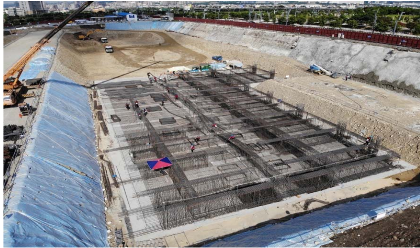
108年8月22日 展覽棟北側地梁鋼筋組立
