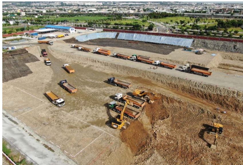
108年7月4日 展覽棟南側土方開挖
