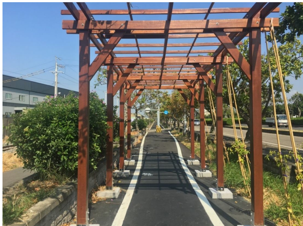
既有花架設施改善
