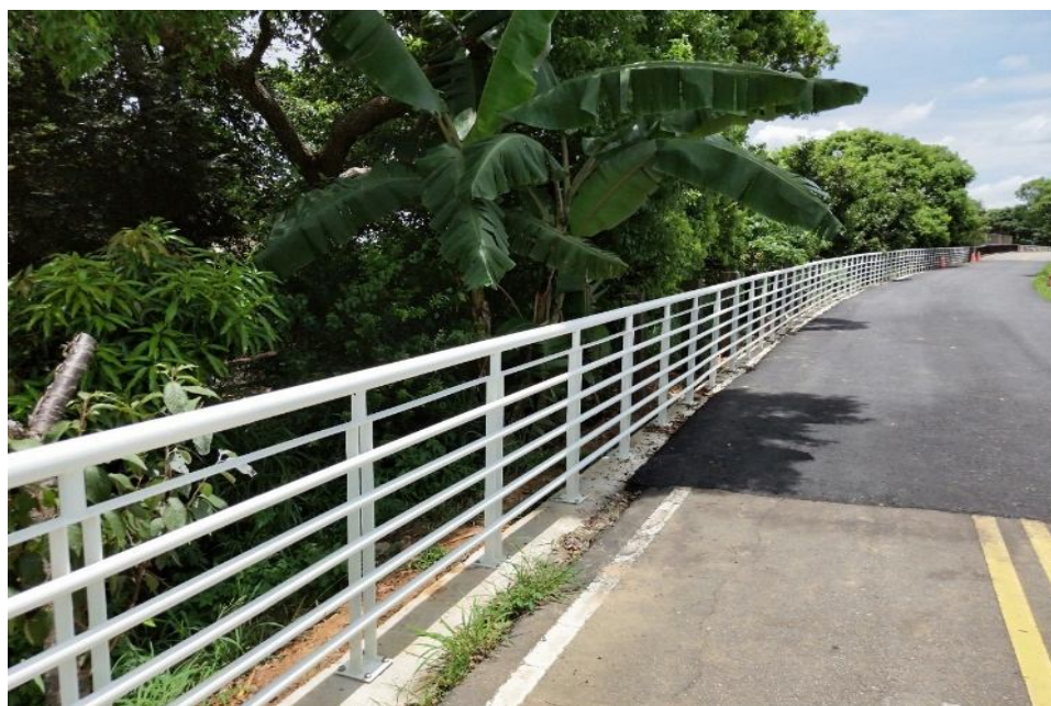
老舊欄杆更換
