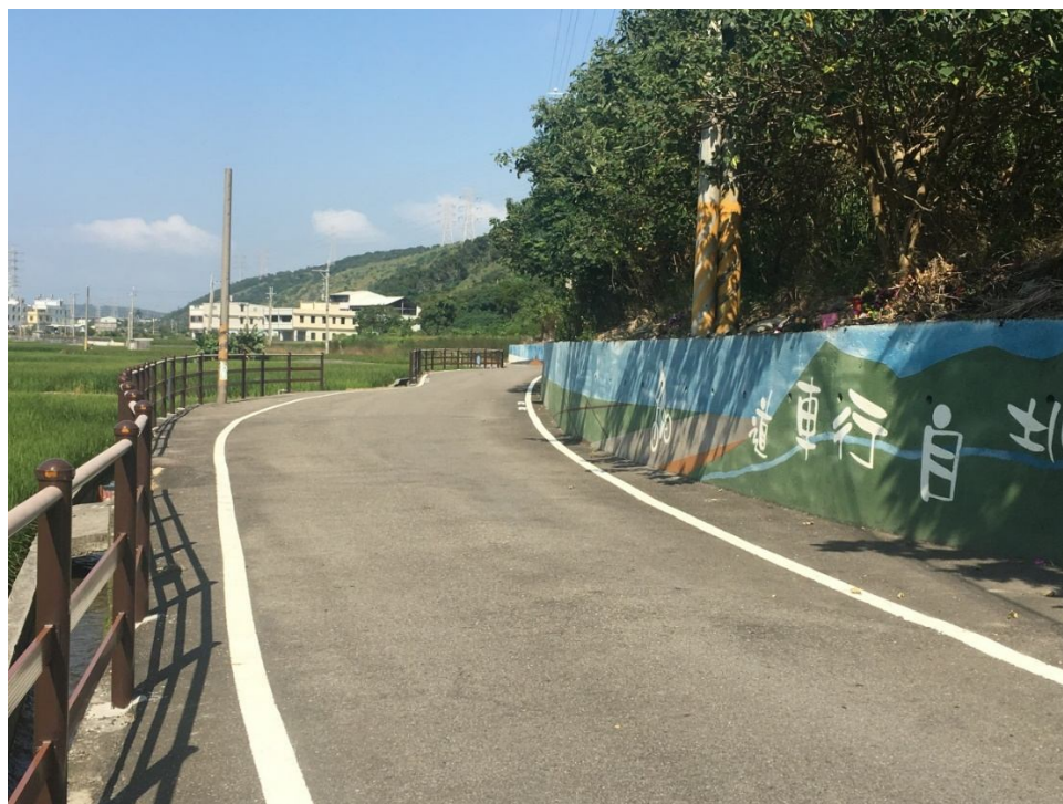
安全護欄設置
