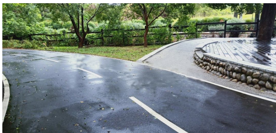
無障礙設施及休憩空間修繕整建
