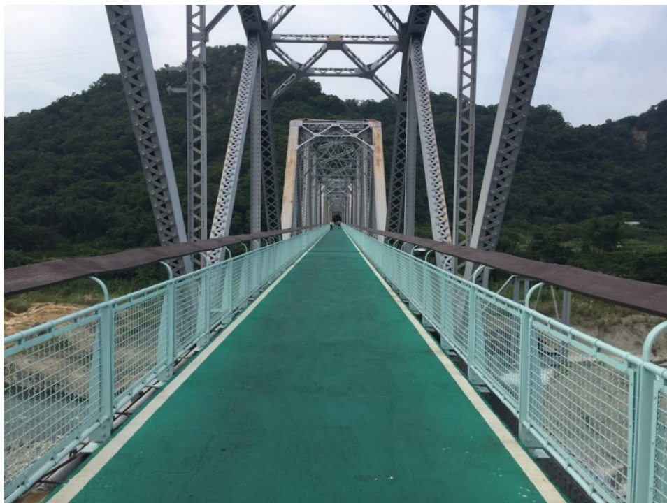
花梁鋼橋欄杆改善
