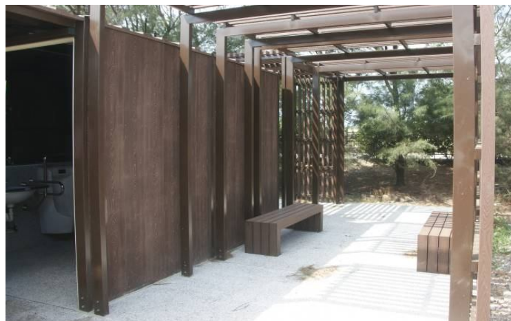
既有廁所設施改善
