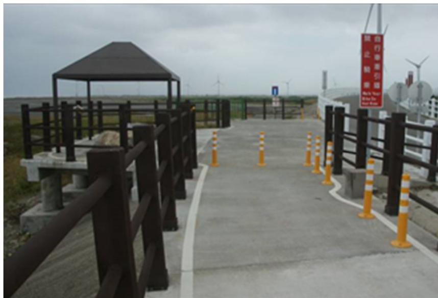
觀景平台設施改善
