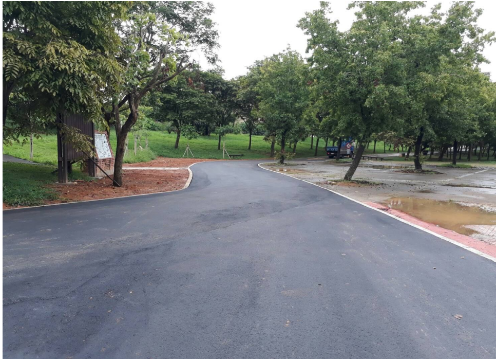
既有鋪面修繕
