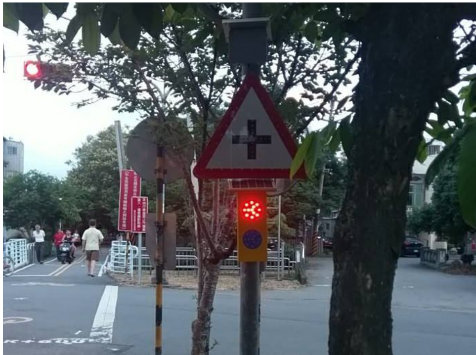
路口夜間警示設置
