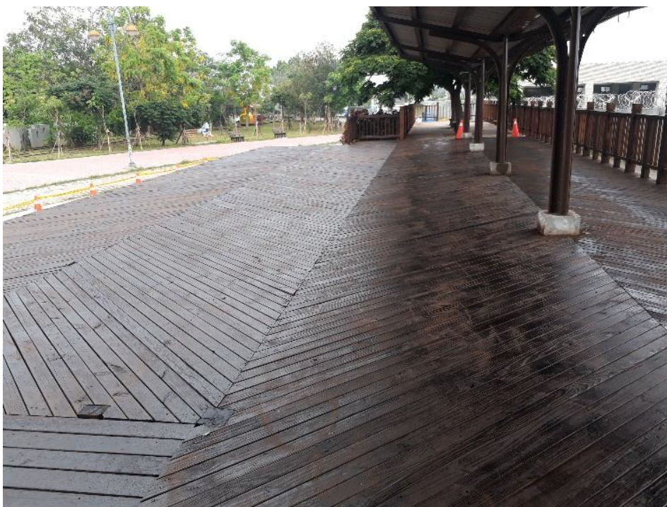
木作設施整修
