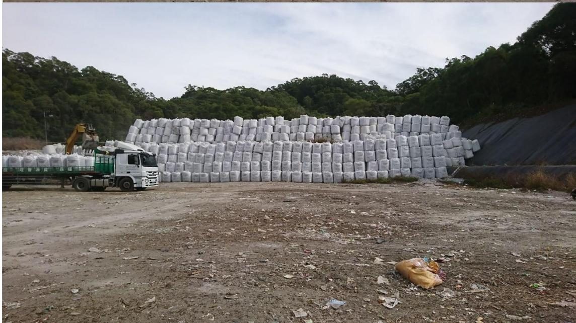
圖 4. 本市后里掩埋場飛灰穩定化物最終處置區
