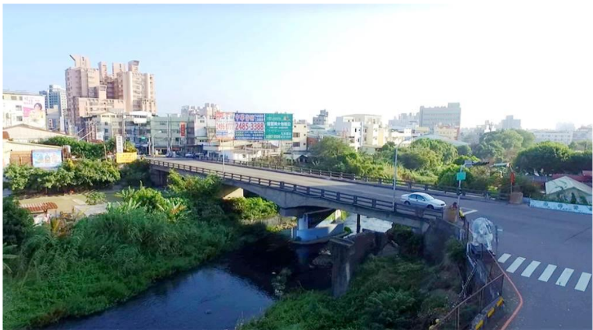
圖 1.2 現況南門橋橋梁型式
