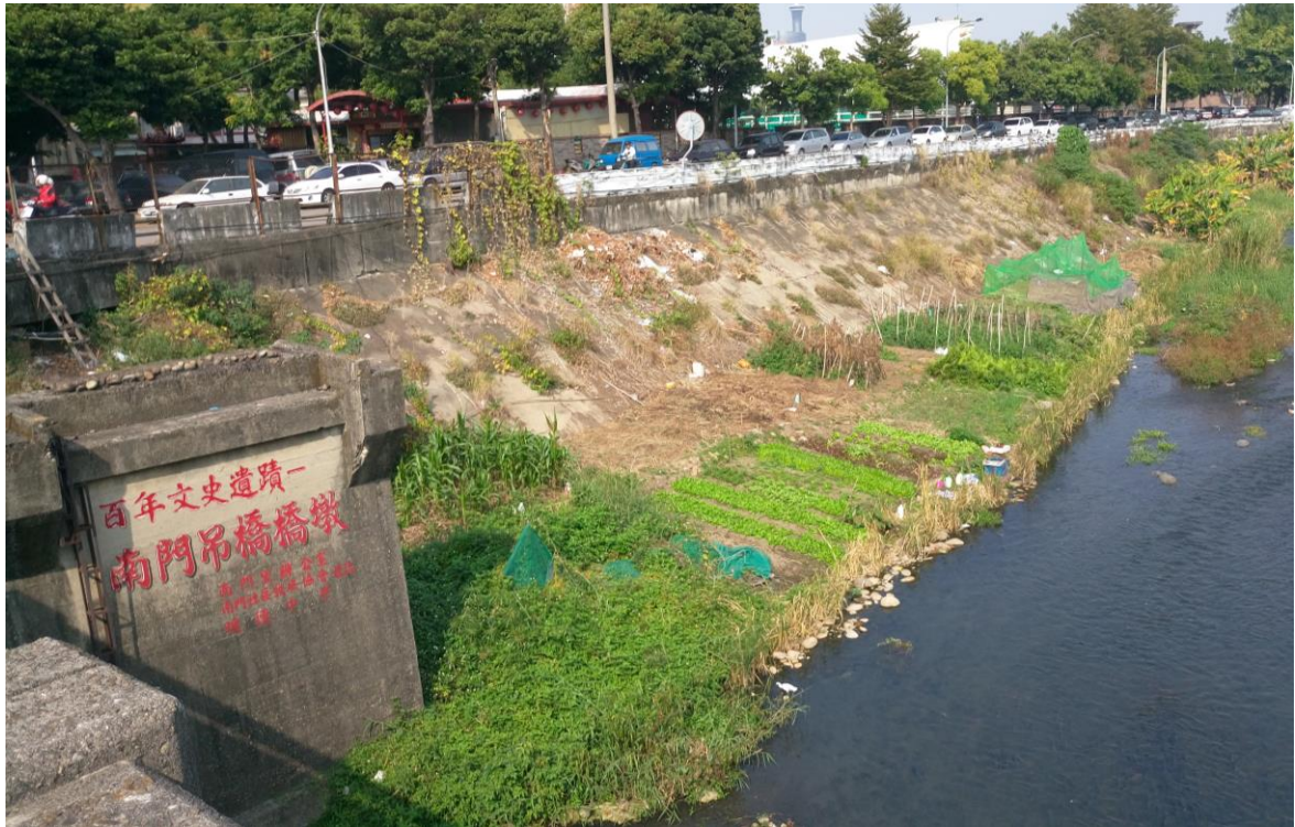
圖 1.5 南門吊橋橋墩舊橋址
