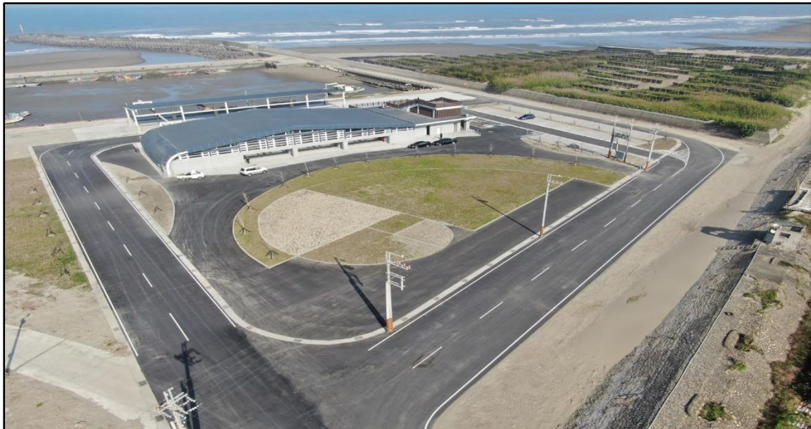
圖 3-本工程全貌照片
