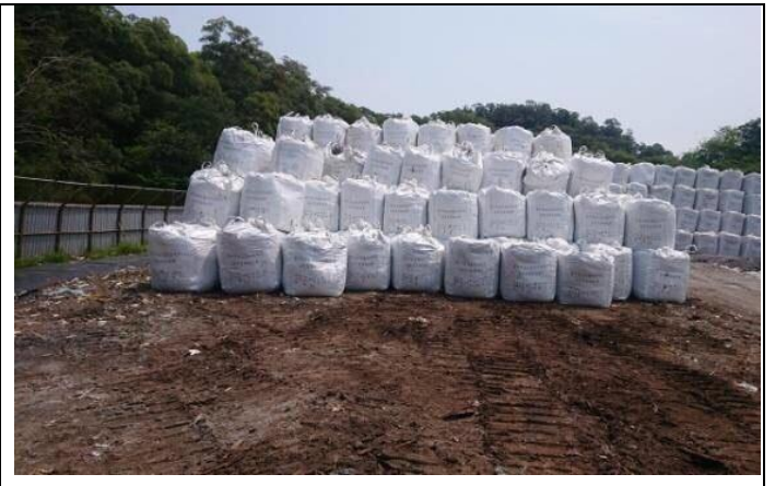
圖 5 本市后里掩埋場飛灰穩定化物最終處置區
