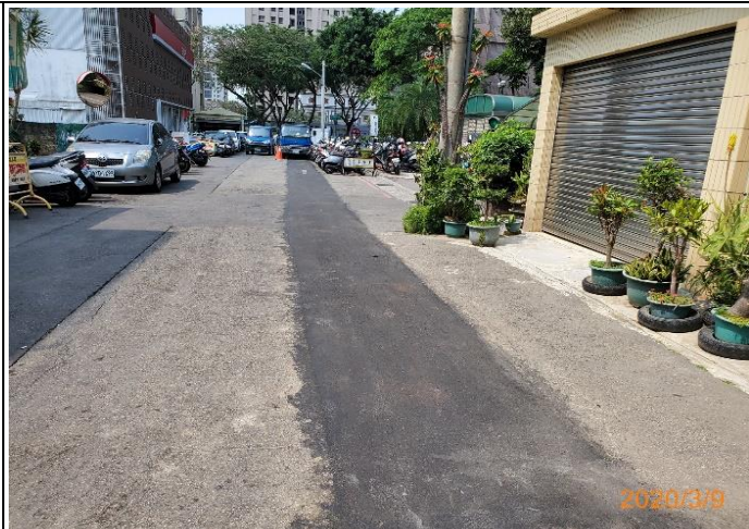
控制性低強度回填材料回填完成
