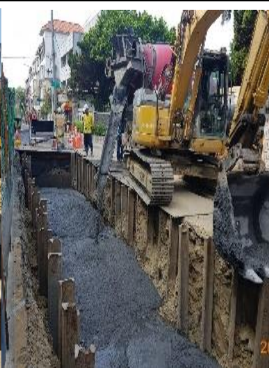
使用控制性低強度回填材料回填作業中
