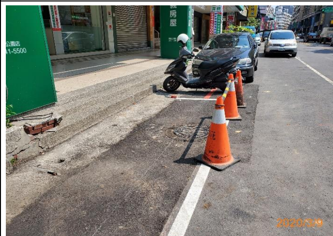
控制性低強度回填材料回填完成
