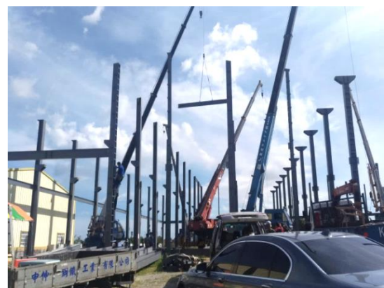
農地施工中違建
