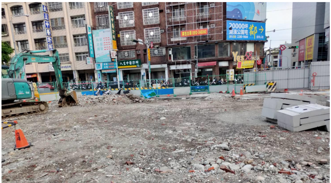
圖 9、大智機車停車場施工狀況
