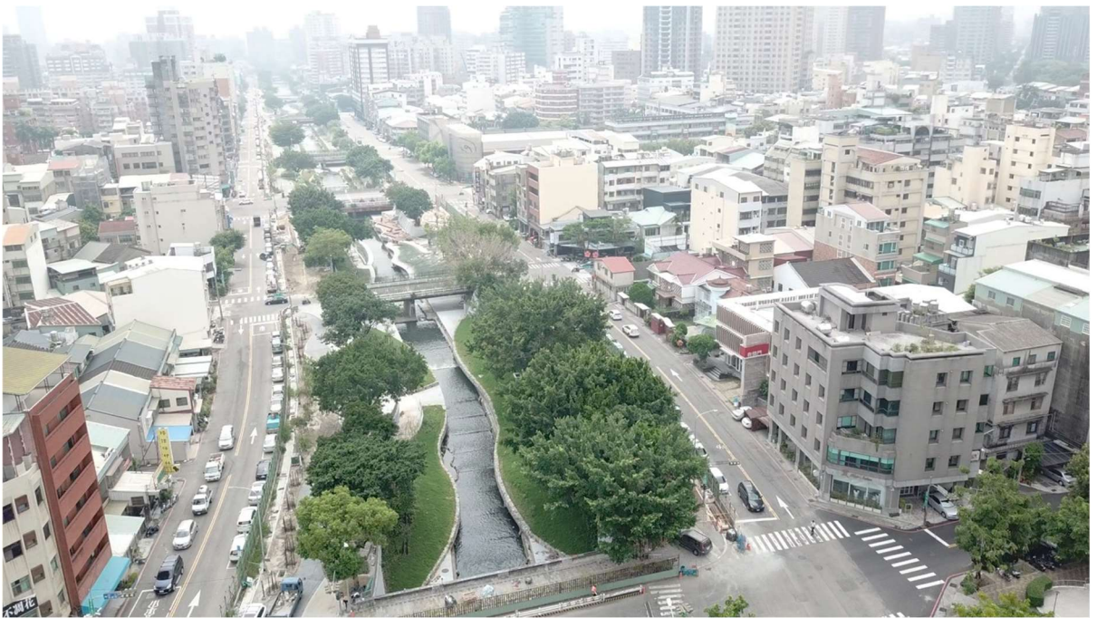
圖 3 民權柳橋至三民柳橋現場空拍照片
