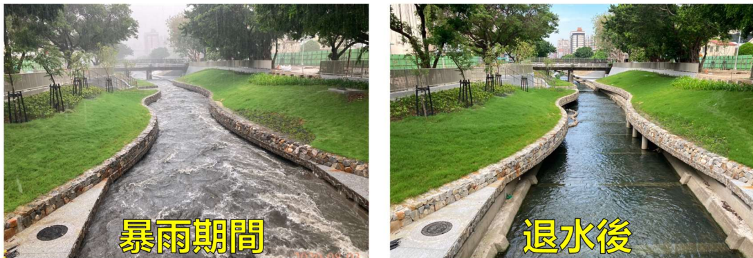
圖 5 柳川二期防洪情形
