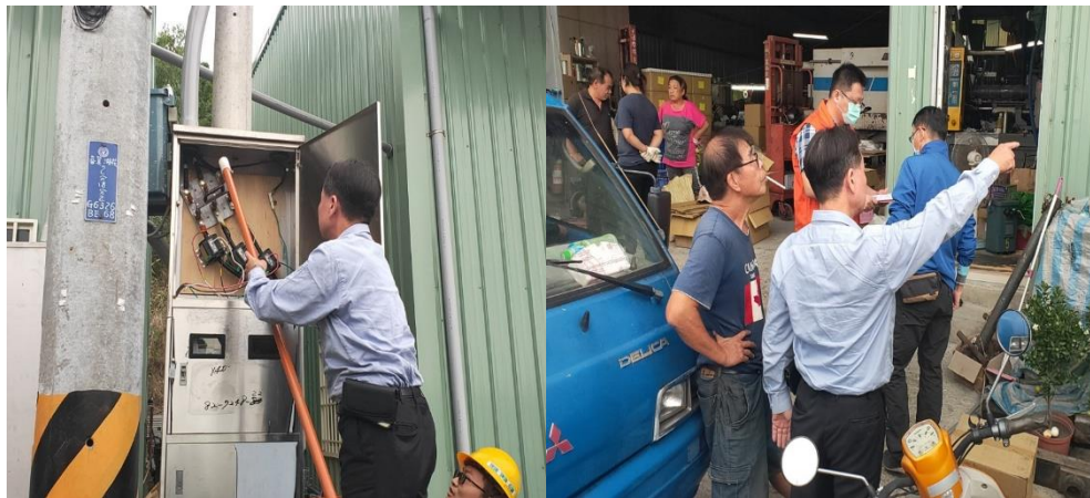
圖3 臺中市未登記工廠執行停止供電、供水作業
