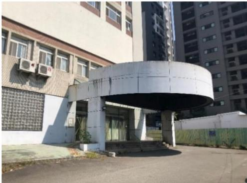
圖 10、南側入口雨庇有裂縫
