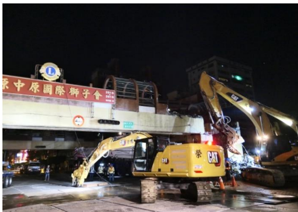
圖 3.2 人行天橋主梁及墩柱拆除作業
