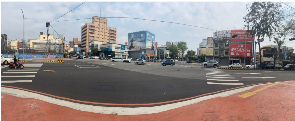
圖 3.4 人行天橋拆除完成現況照
