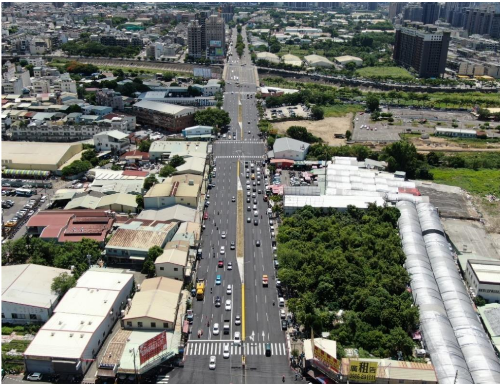
圖 2.2 太原路地下道填平後空拍圖(太原車站東側)
