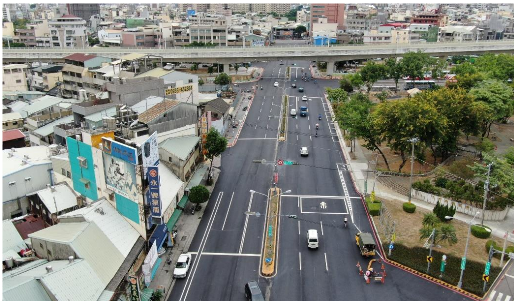
圖 2.5 建成路地下道填平後空拍圖
