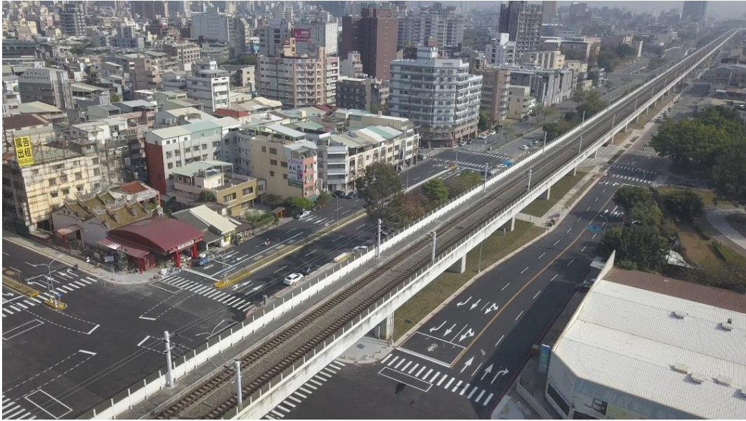
圖 2.7 五權路地下道填平後空拍圖(建國南北路)
