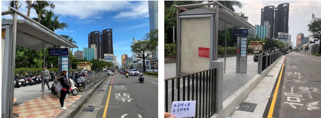
圖 4.4 忠明路口施工前後對照圖
