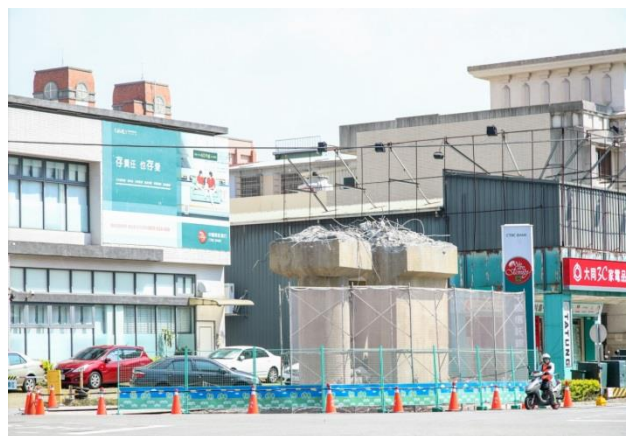
圖 3.2 人行天橋主梁及墩柱拆除作業
