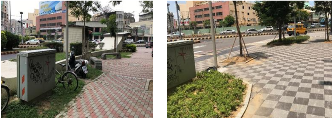
圖 4.6 五權路口施工前後對照圖
