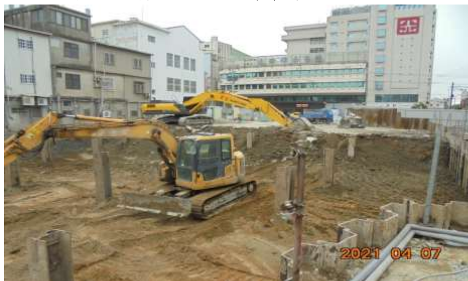
圖 44 沙鹿區沙田立體停車場施工照片
