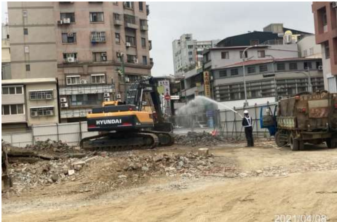
圖 42 中區興中立體停車場施工照片
