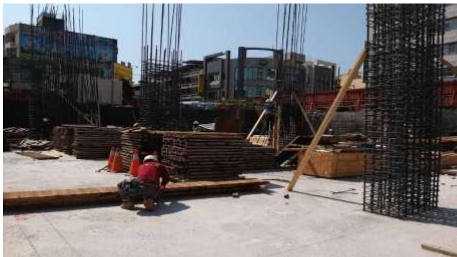
圖 40 潭子區潭興立體停車場施工照片
