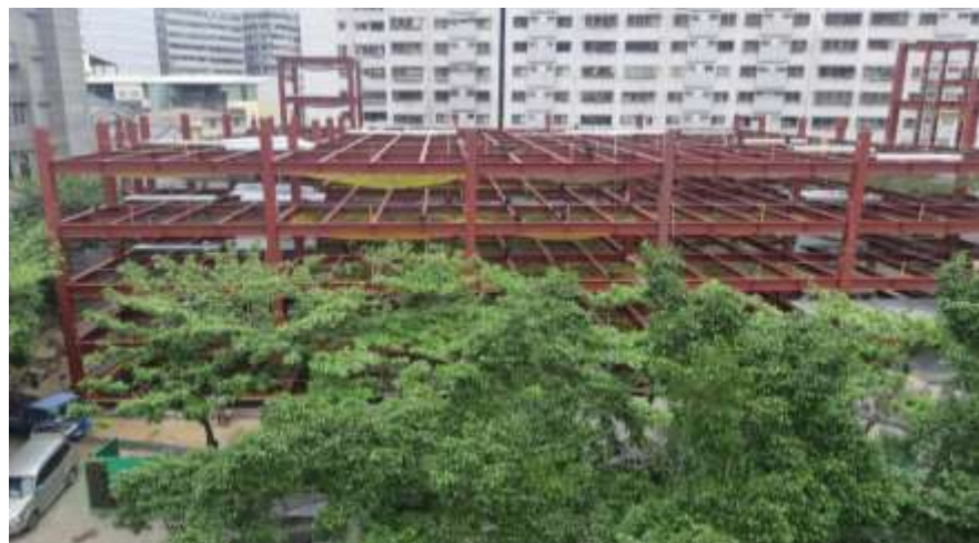
圖 38 南屯區正心立體停車場施工照片
