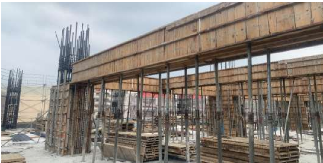
圖 36 大里區東榮立體停車場施工照片
