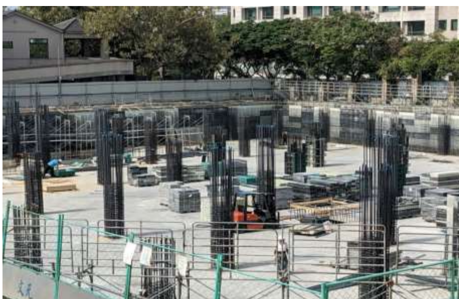
圖 34 北屯區舊社地下停車場施工照片
