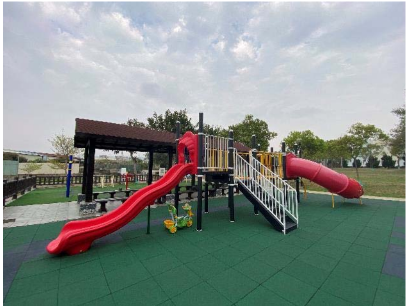
圖45、組合遊具滑梯(龍井區拍瀑拉公園)
