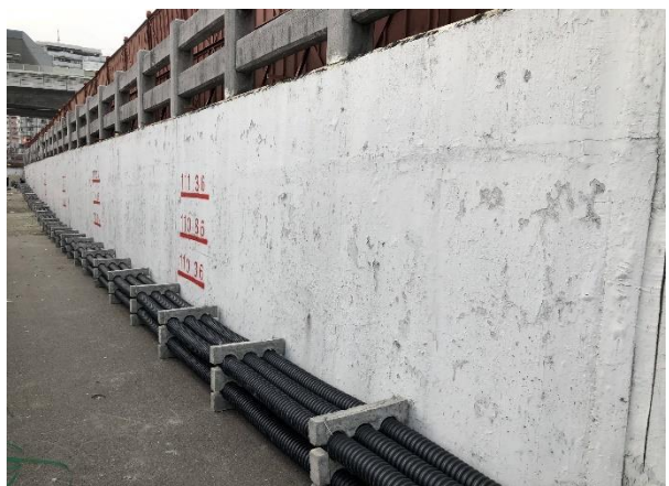
寬頻管道建置
