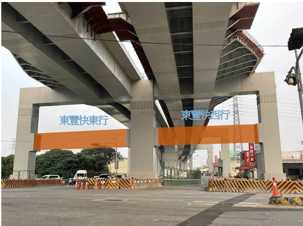
圖 6-4 豐潭段留設東豐快接合板現況
