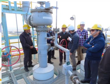
國營事業臨廠(場)安全衛生輔導- 台灣中油天然氣事業部
