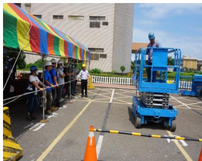
高空作業車作業安全觀摩情形
