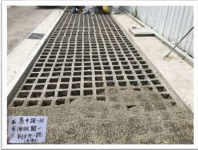
透水步道施工照片
