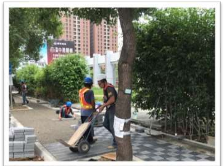
透水步道施工照片
