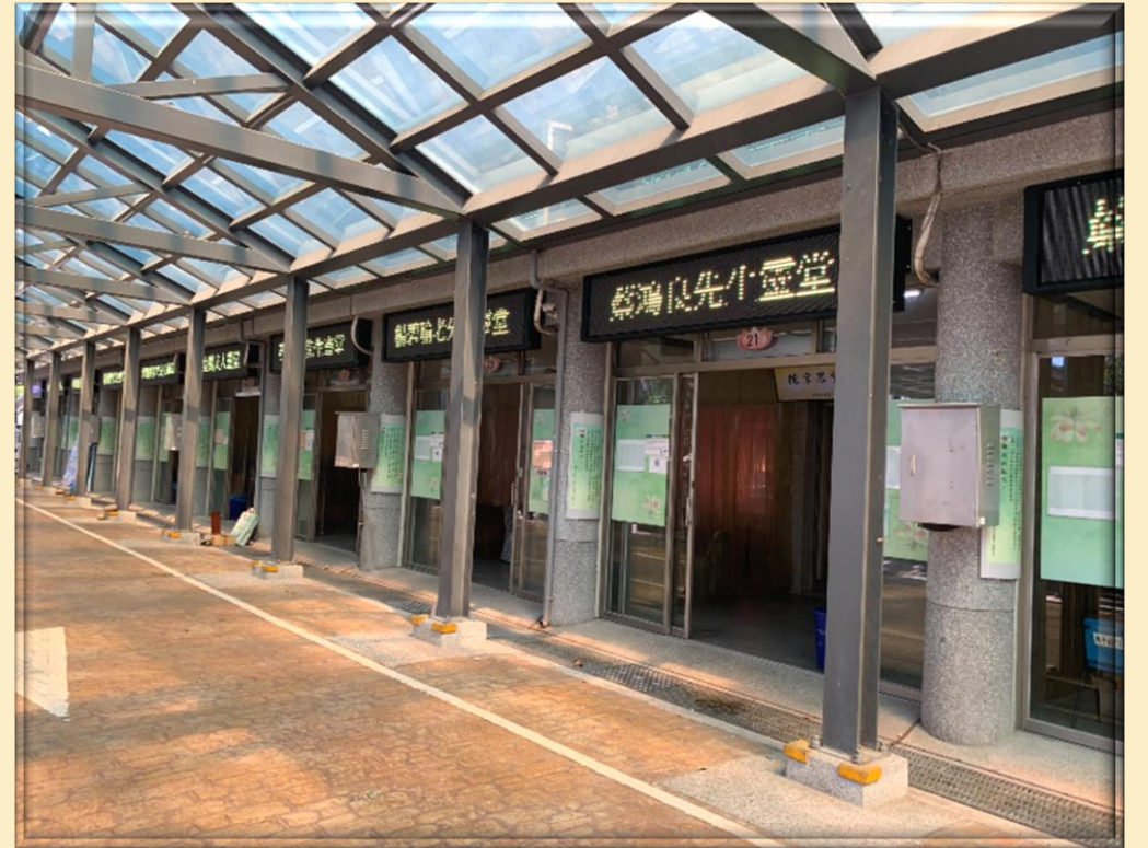
大甲殯儀館小靈堂全面完成電子牌樓設置
