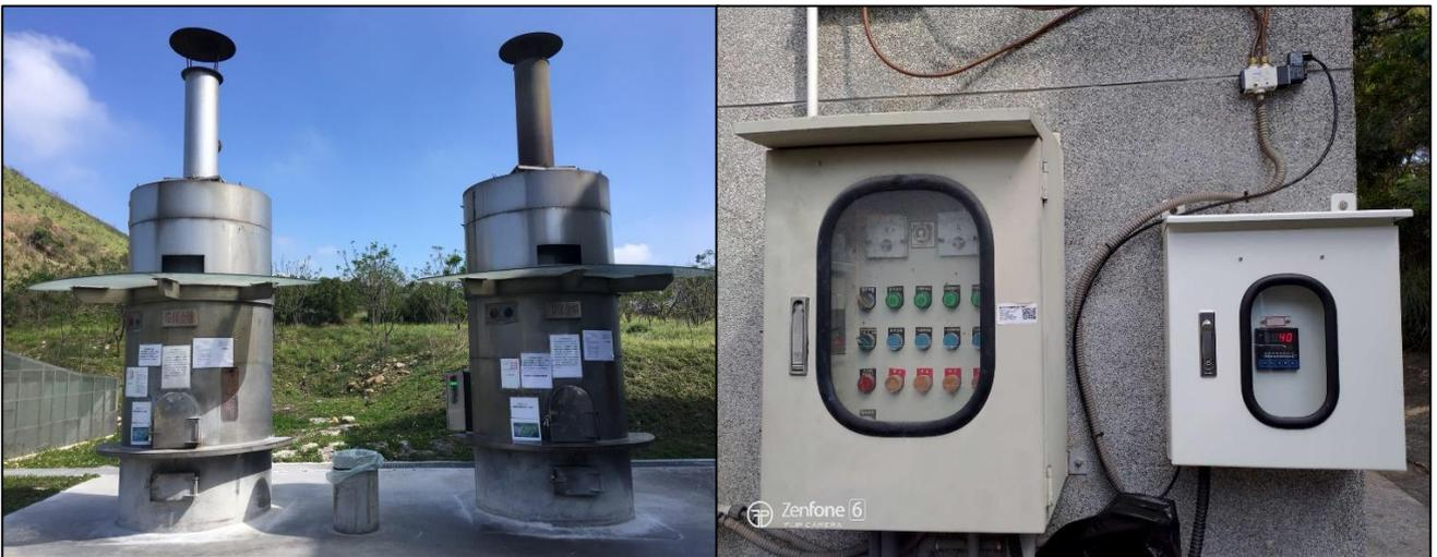
圖八、大甲館金爐換修增設蜂鳴警報器，改善空汙防制自動化
