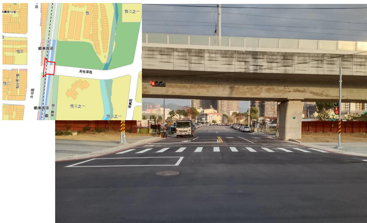
圖6 20M-1計畫道路完工照片
