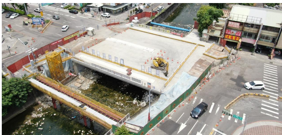
牛埔橋施工現況圖(目前施工進度已達 60%)
