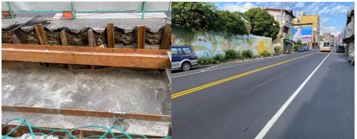
烏日區學田路雨水下水道工程施工中及完工後照片
