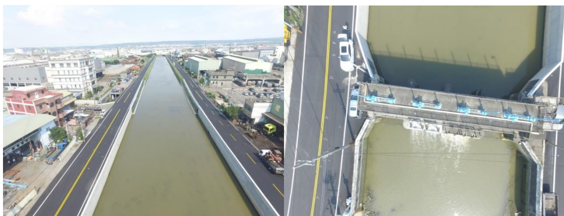
安良港改善工程完工空拍照片
