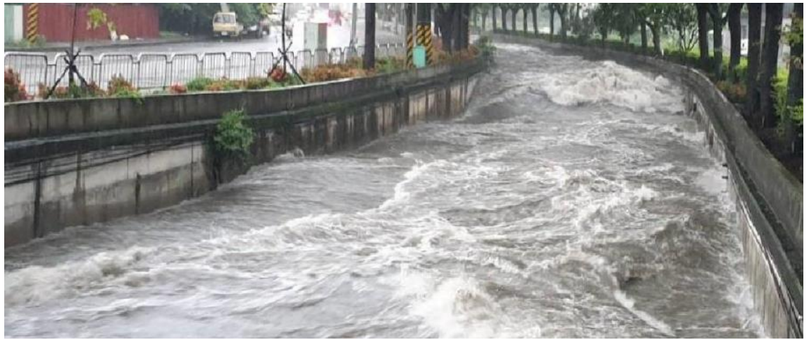
渠底改善及護岸加高後沿線並無溢堤(今(111)年6月)
