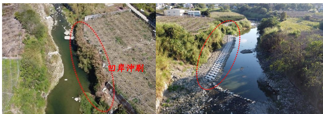
建安橋下游右岸施工前
