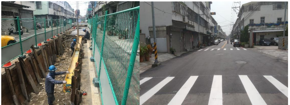
太平區鵬儀路雨水下水道延續工程施工中及完工後照片
