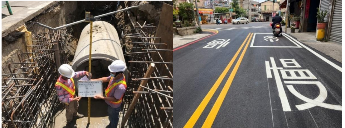
潭子仁愛路雨水下水道工程施工中及完工後照片
