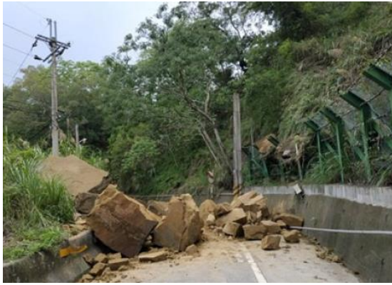
施工前落石造成道路中斷照片
