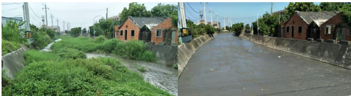
四好溪排水(東西二路橋下游~長壽路上游)清理河段前後照片
