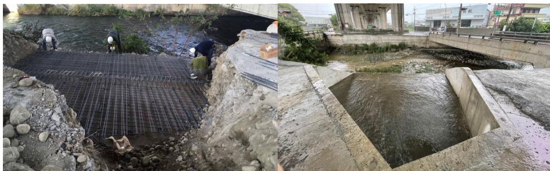
豐原區國豐路三段雨水下水道工程施工中及完工後照片
