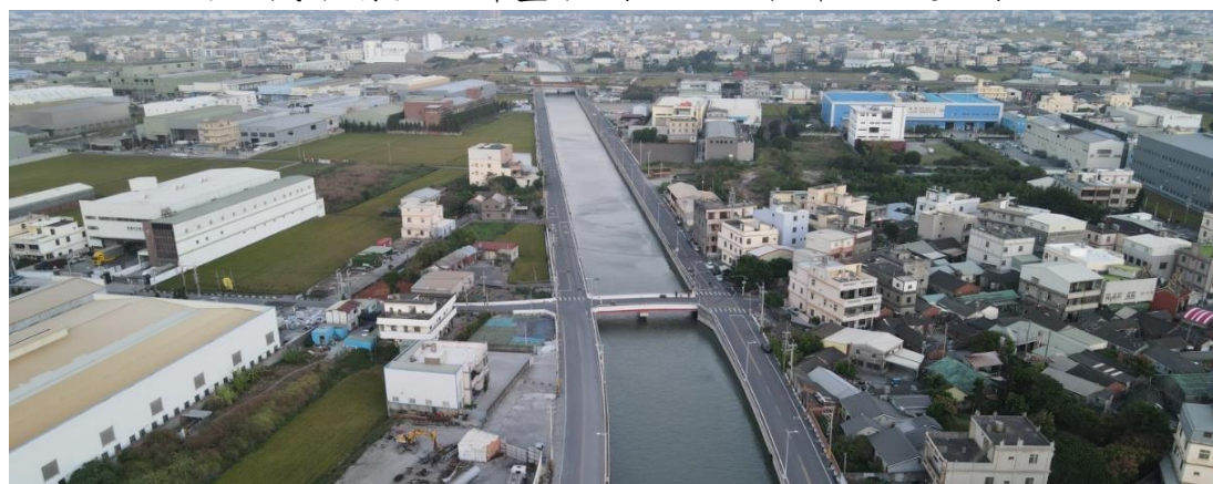
南山截水溝整治計畫第一期工程完工空拍照片
