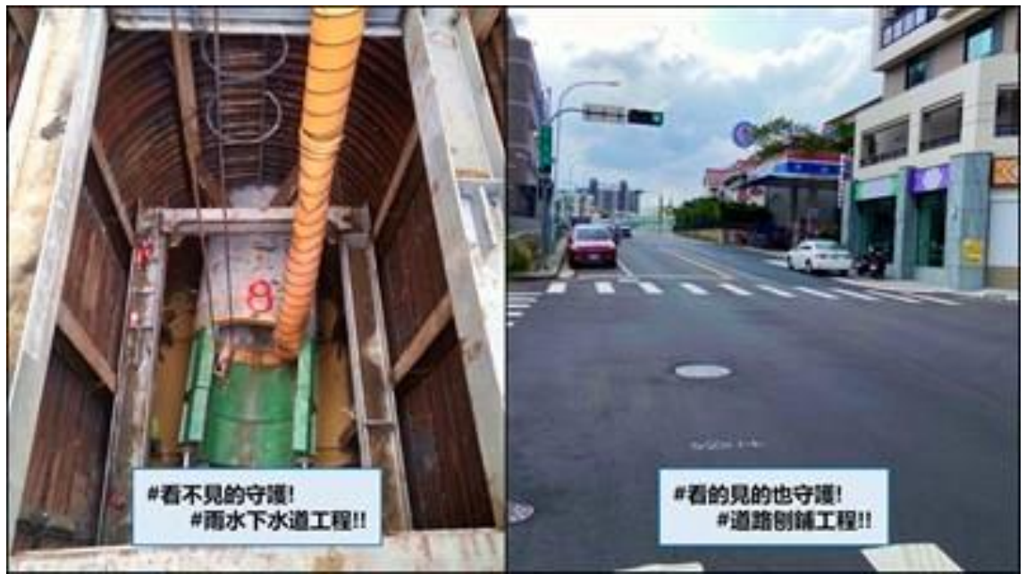
東區旱溪街雨水下水道工程施工中及完工後照片
