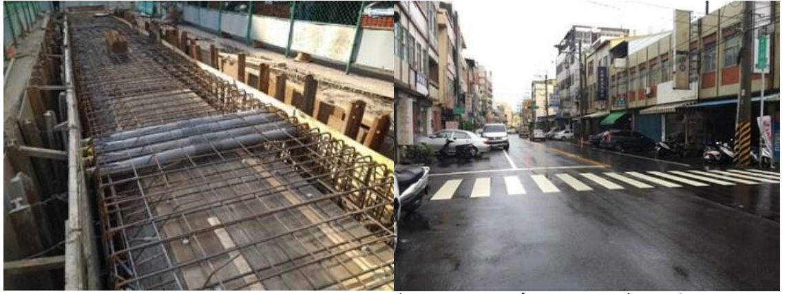
大甲區興安路雨水下水道工程施工中及完工後照片
