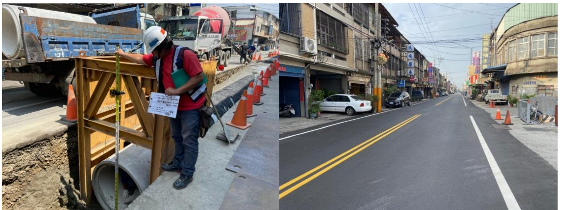
高美路排水後續工程施工中及完工後照片
