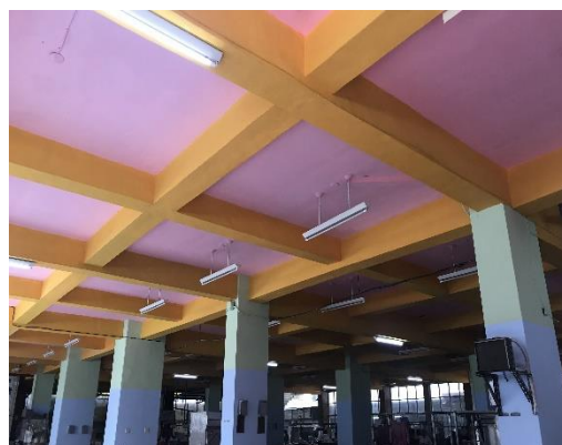
圖二 后里第一市場擴柱耐震補強
