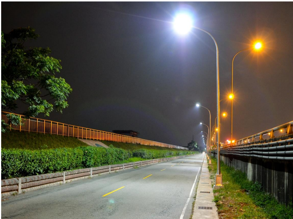
圖 7 筏子溪水防道路提升夜間照度
