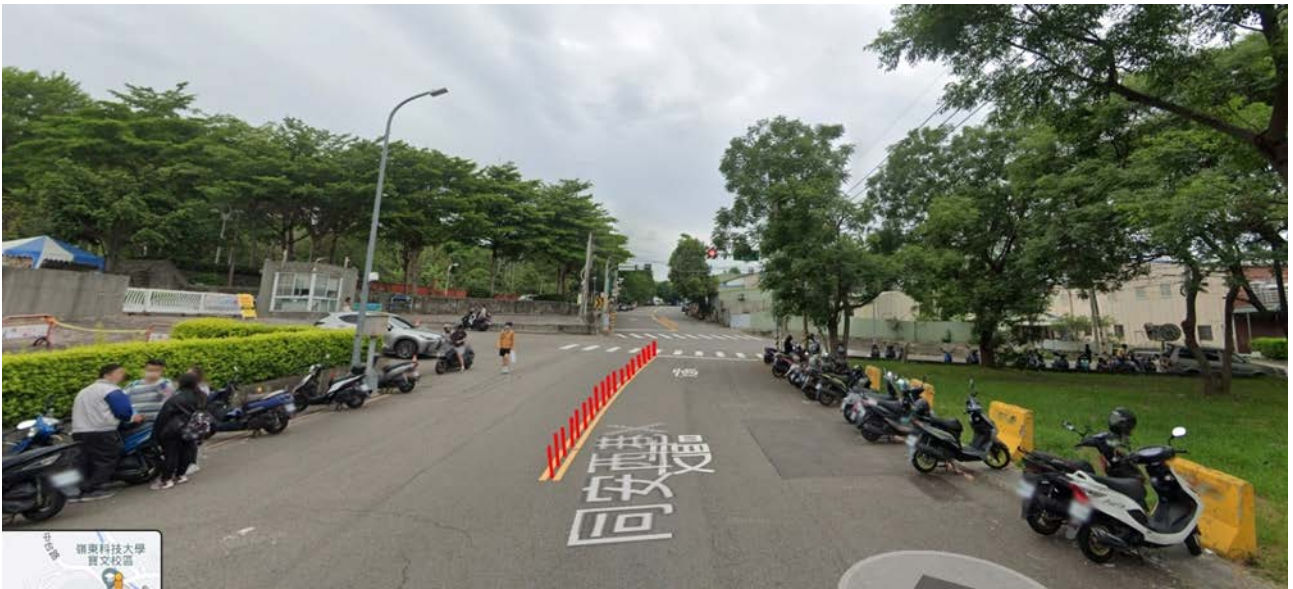
圖一 同安西巷雙黃線設置阻隔設施
