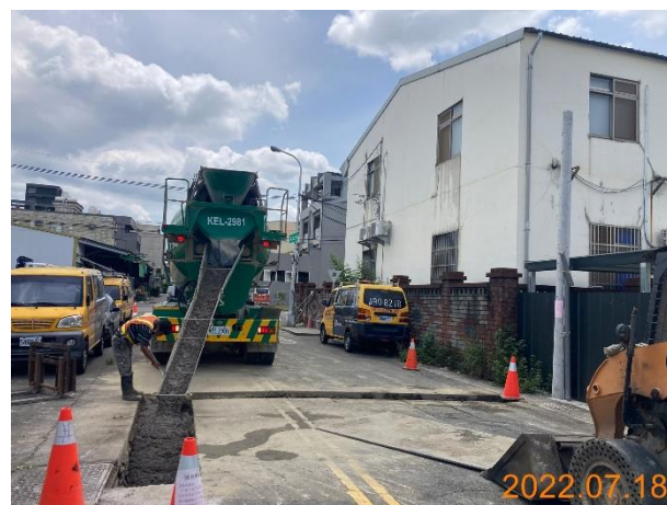
使用控制性低強度回填材料回填作業中
