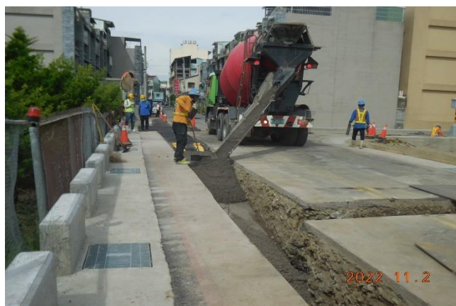
使用控制性低強度回填材料回填作業中
