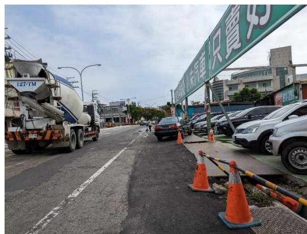
控制性低強度回填材料回填完成
