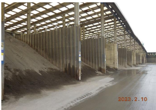
底渣再利用廠-再生粒料貯存區
