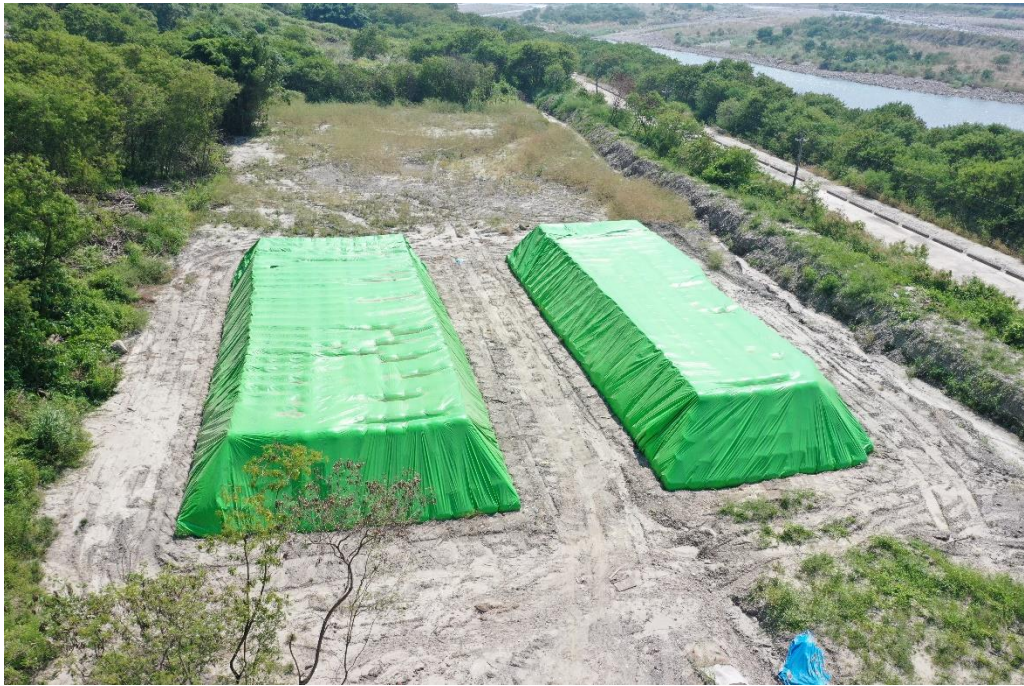
圖 6、打包物覆蓋不透水材料之示意照片
