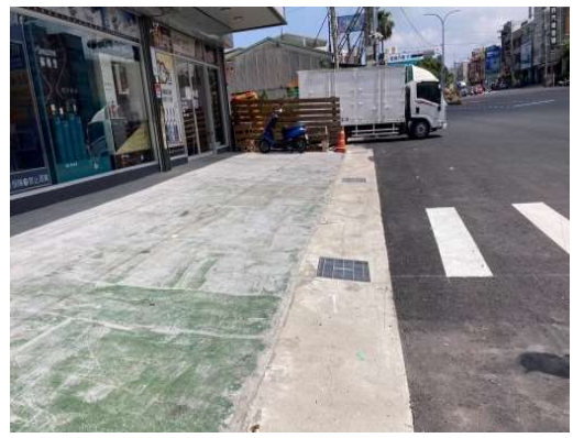
大甲區中山路側溝重建完成
