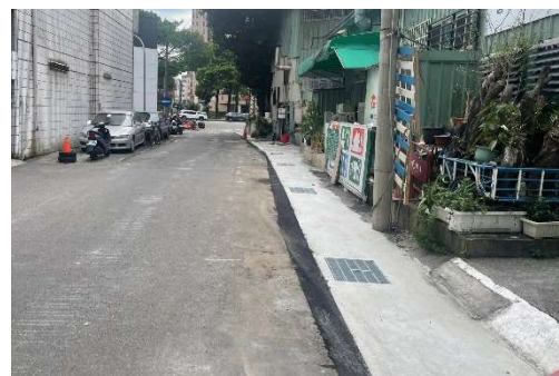
北區衛道路側溝重建完成
