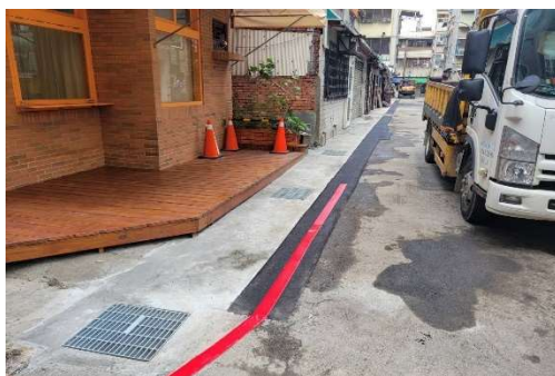
西區中美街側溝重建完成
