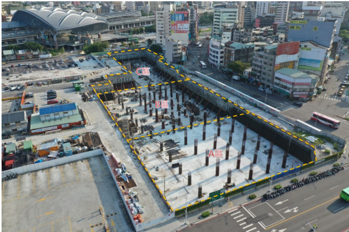
圖 9、大臺中轉運中心現況施工照片
