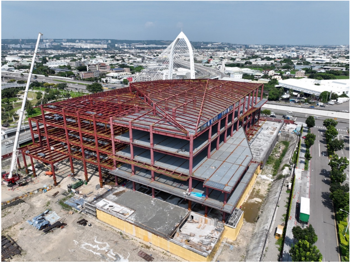
圖 10、水滴轉運中心現況施工照片
