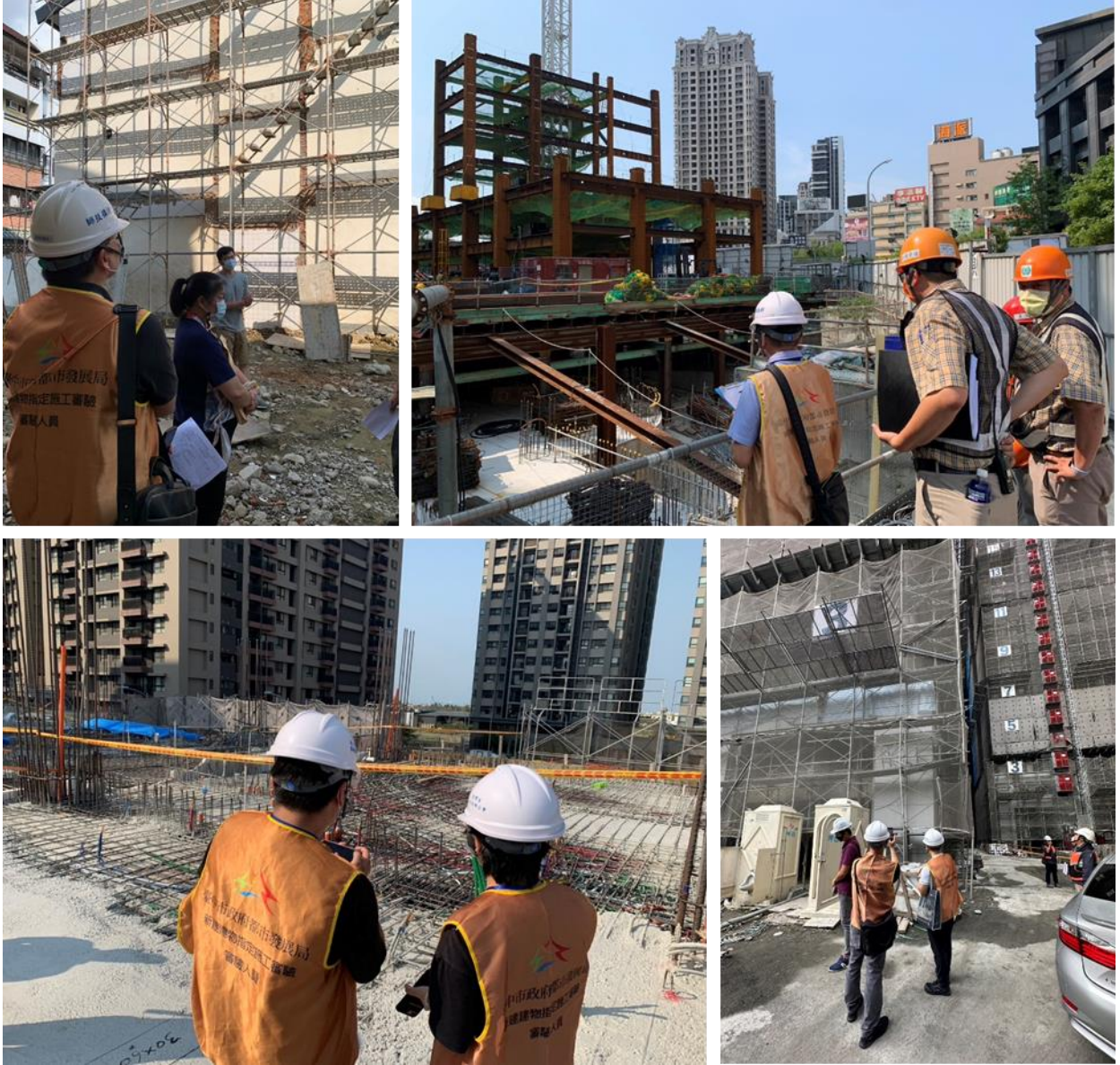
圖6、施工勘驗現場照片
